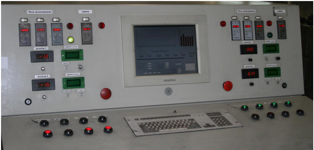
Фото 1П2. Пульт управления линией- ЕС620А по производству ГФ.
